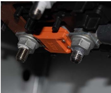
Verbauter Sicherungshalter mit 150 A Sicherung (Mercedes 906, VW)
